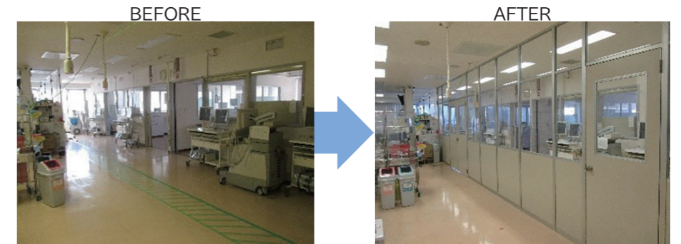
施設改修の例：集中治療室に感染対策のための間仕切りを設置
