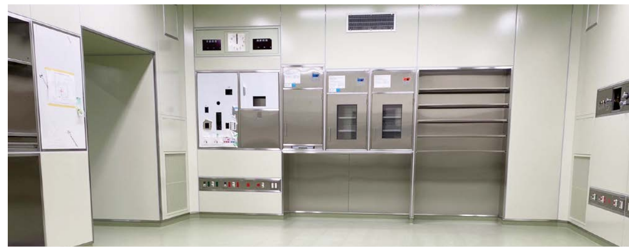
完成した手術室。これから手術機械を入れます。
