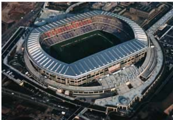
横浜市国際総合競技場
