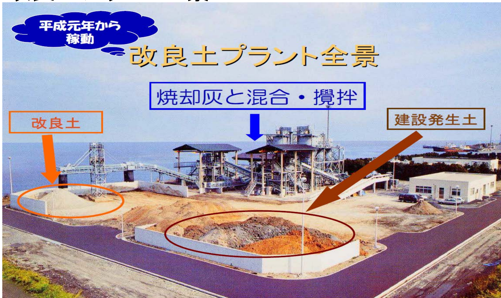
図. 6 改良土プラント全景
