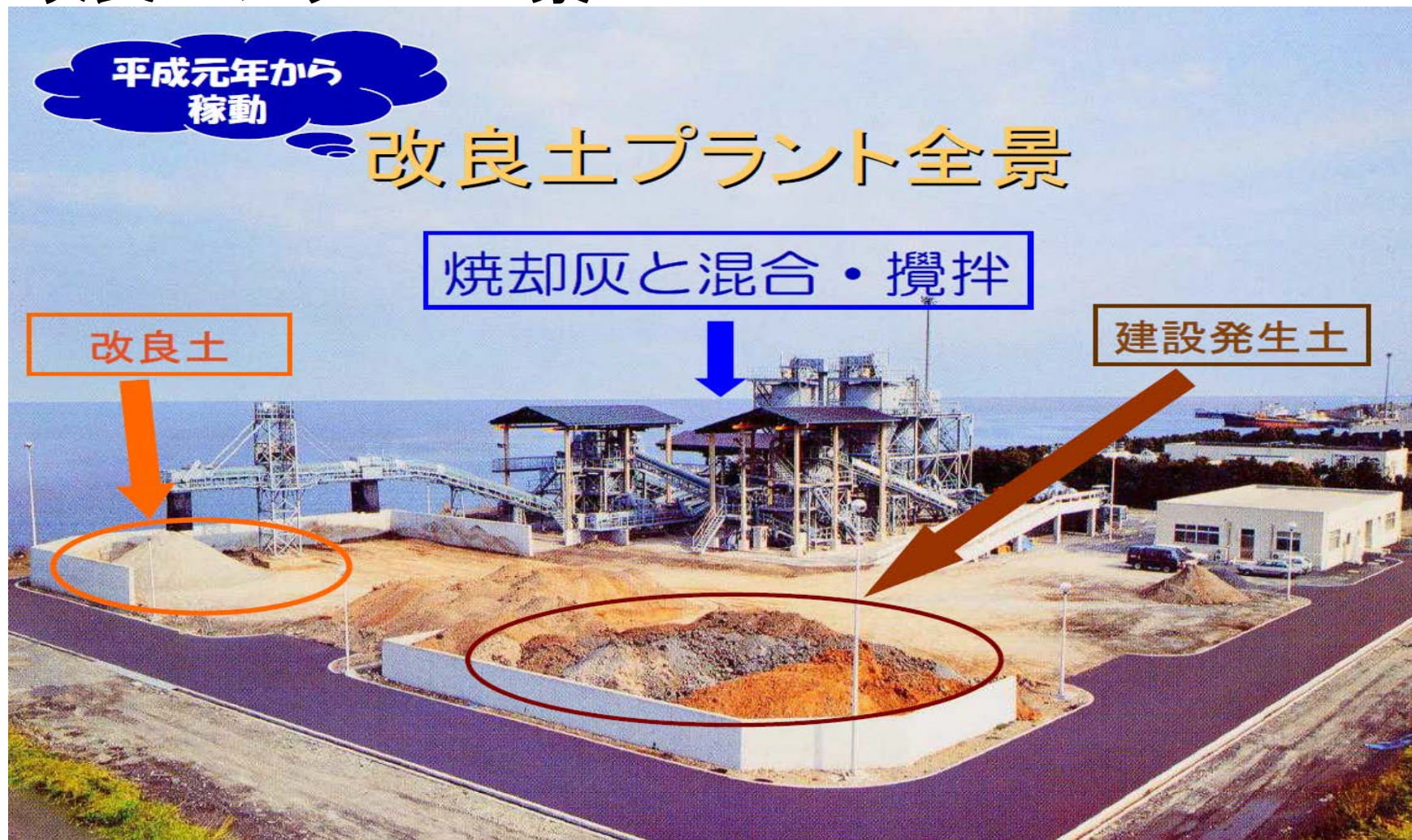
図. 6 改良土プラント全景
