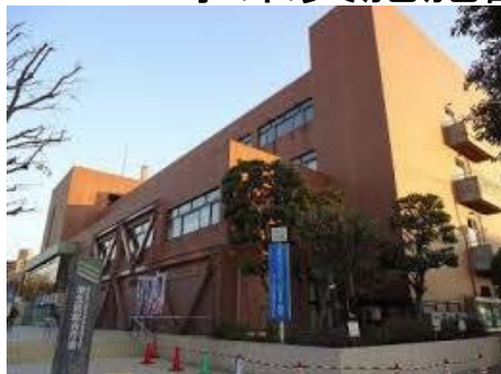
横浜市港北区総合庁舎
