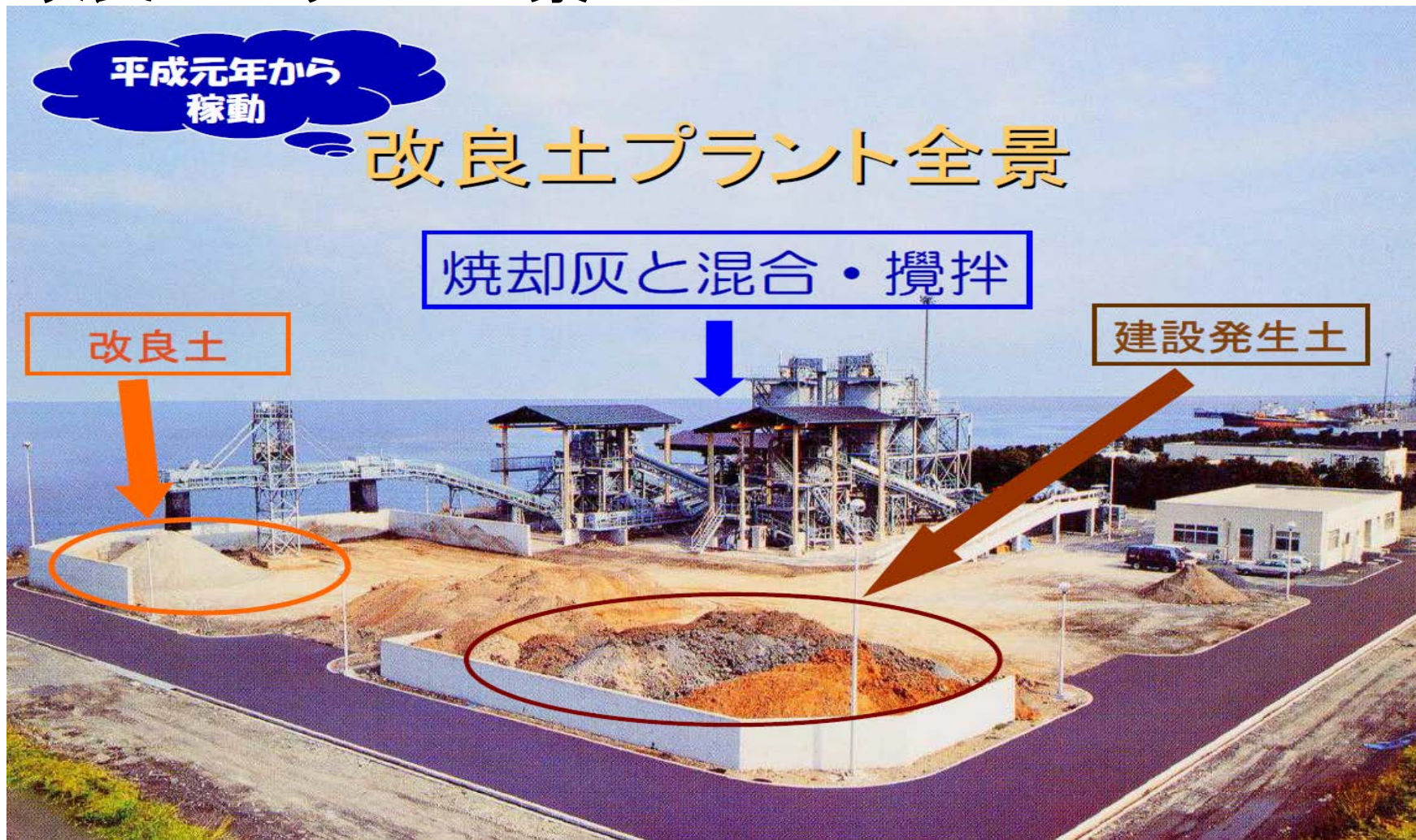
図. 6 改良土プラント全景
