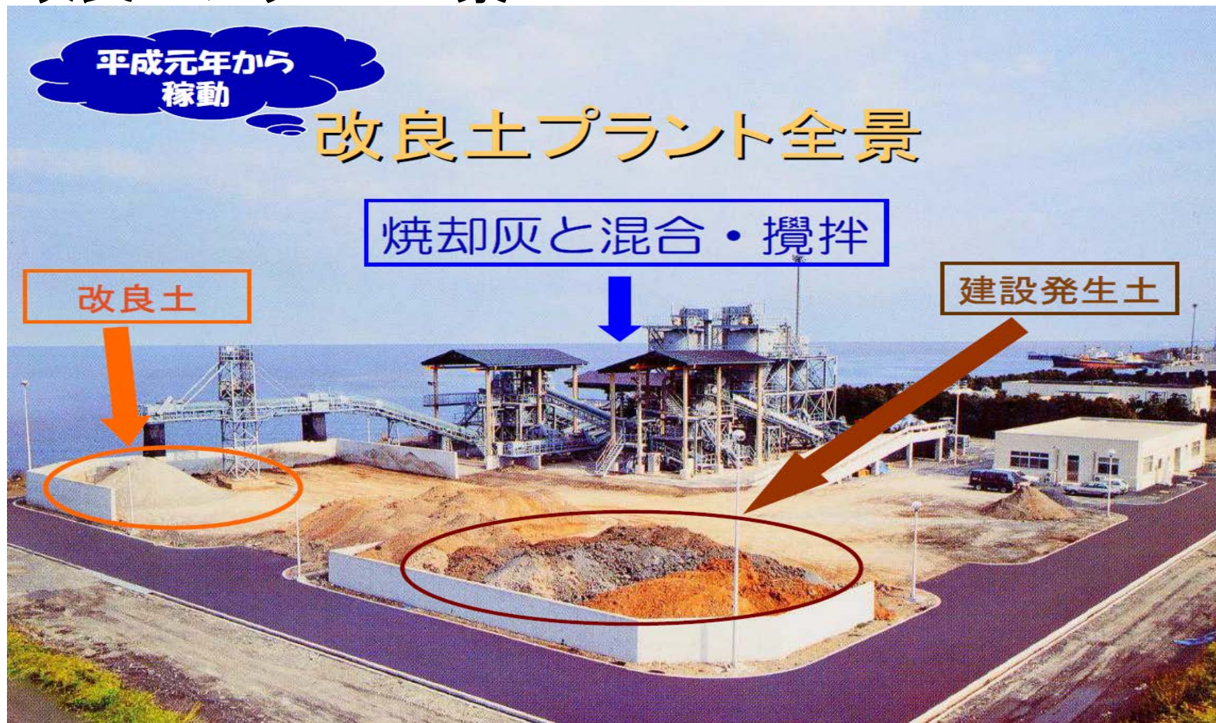
図. 6 改良土プラント全景
