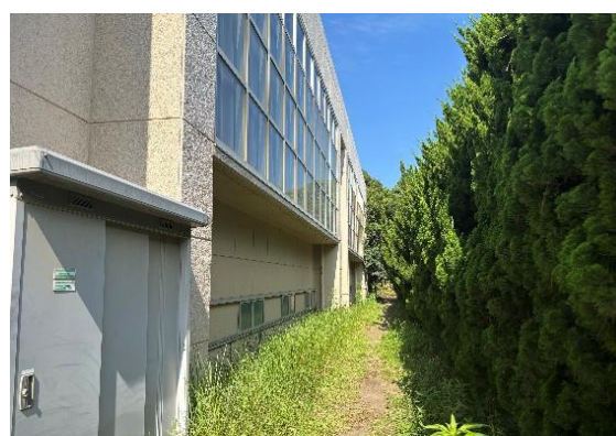
<室外機設置予定外部>
