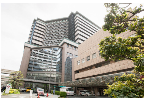
外観北東面4.jpg
