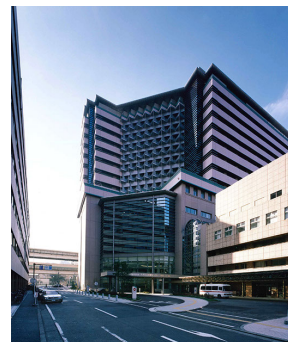
外観北東面2.jpg
