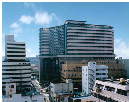
外観北東面1.jpg
