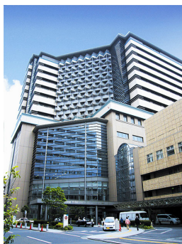
外観北東面3.jpg
