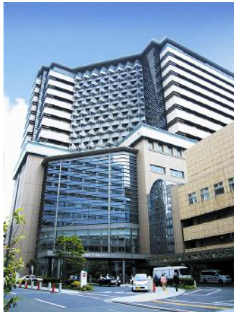
外観北東面3.jpg
