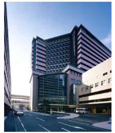
外観北東面2.jpg
