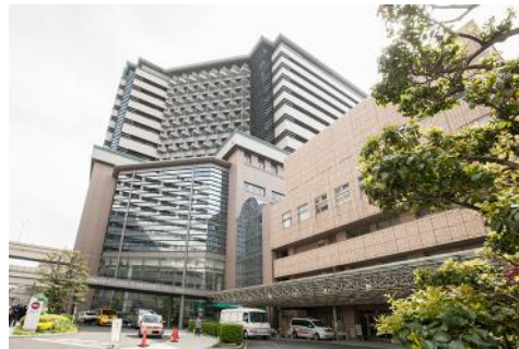
外観北東面4.jpg
