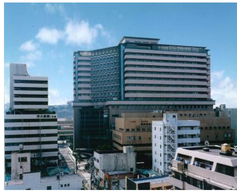
外観北東面1.jpg
