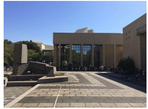
外観へボンホール3.jpg
