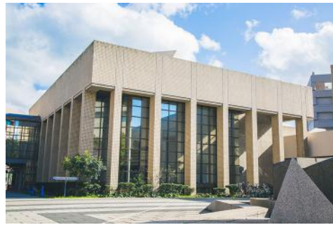
外観へボンホール5.jpg
