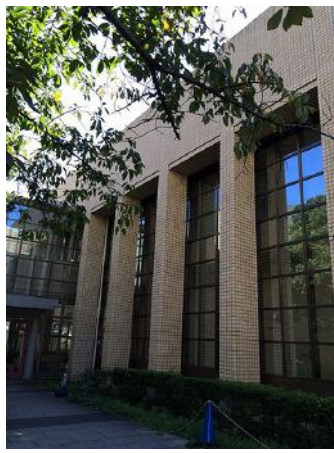
外観へボンホール2.jpg
