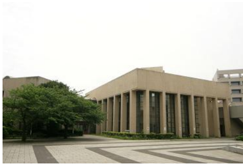
外観へボンホール1.jpg
