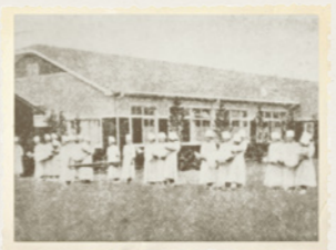
1924年 大震災後の仮病院
