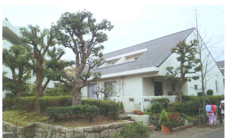
中低層住宅も配置され心地よい空間をつくる1つの要因となっている
